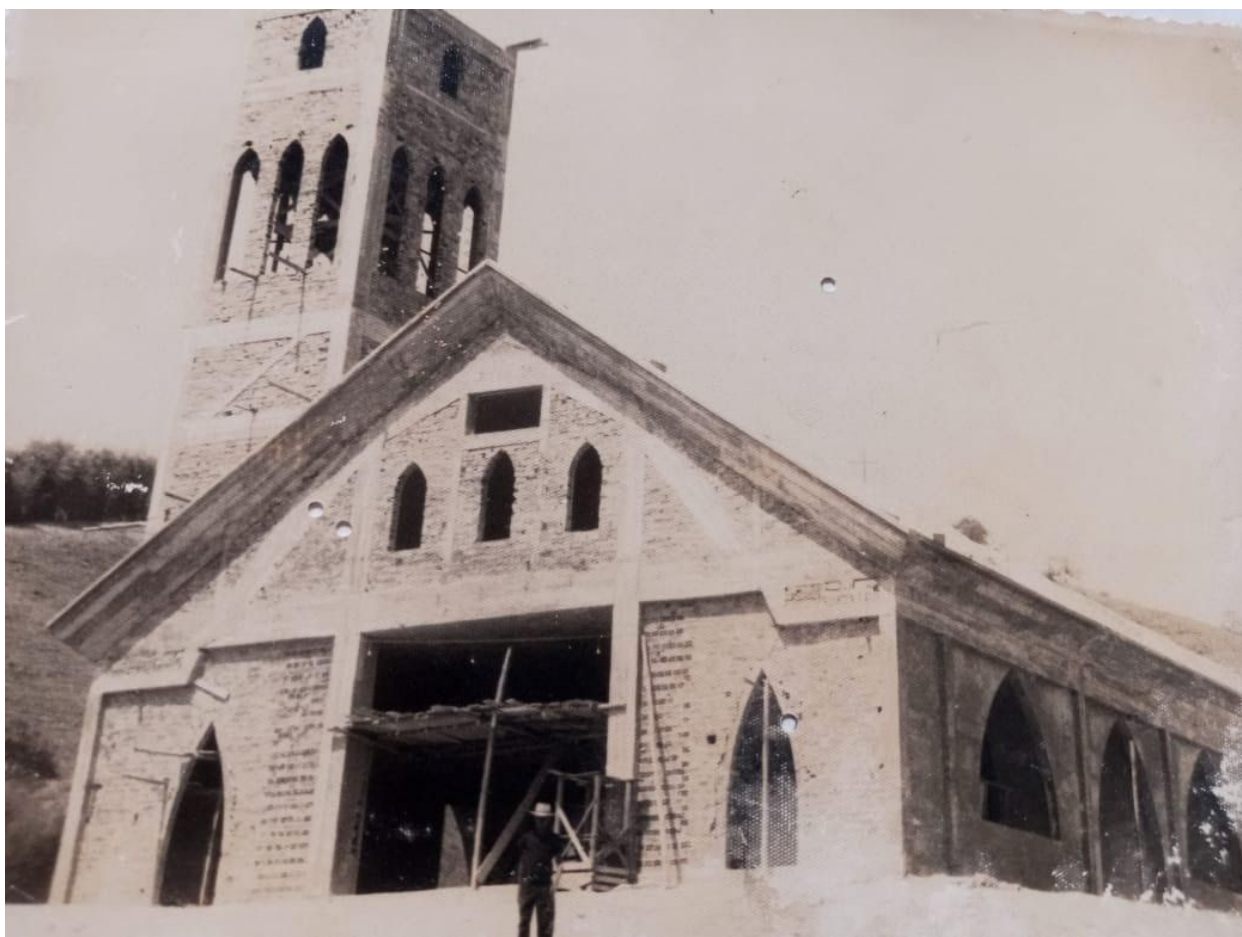
Figura 19: Processo de construção da Igreja Matriz de Dionísio- MG. 1962. Arquivo da Igreja Matriz.
